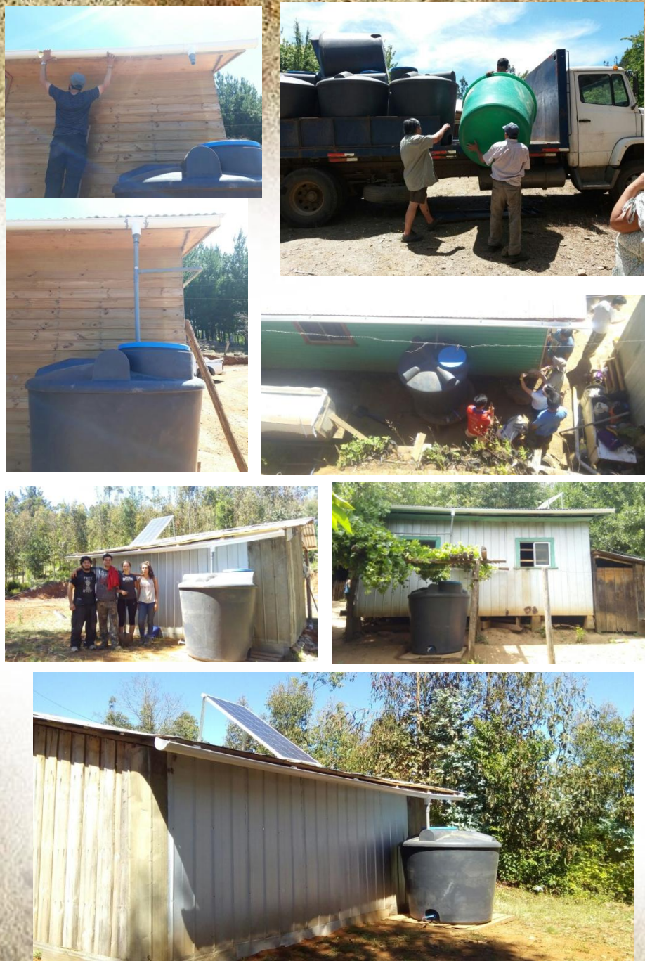
Figura 3. Registro fotográfico del proceso de instalación de los sistemas de captación de aguas lluvia
