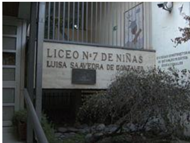
Figura 1. Fachada actual de Liceo 7
